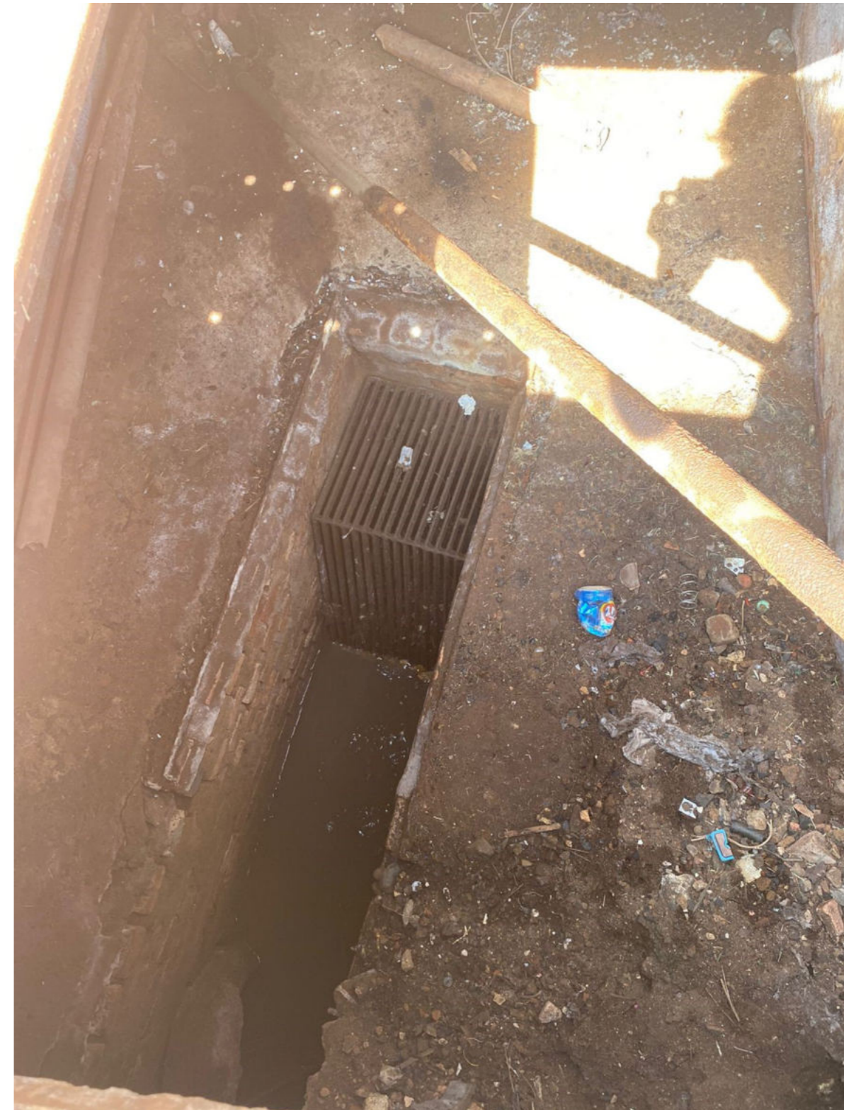
Figura 144 – Gradeamento da EEE Quinze de setembro.
