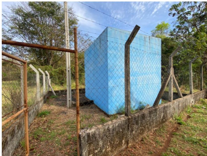
Figura 90 – Fachada Booster Itapema.
