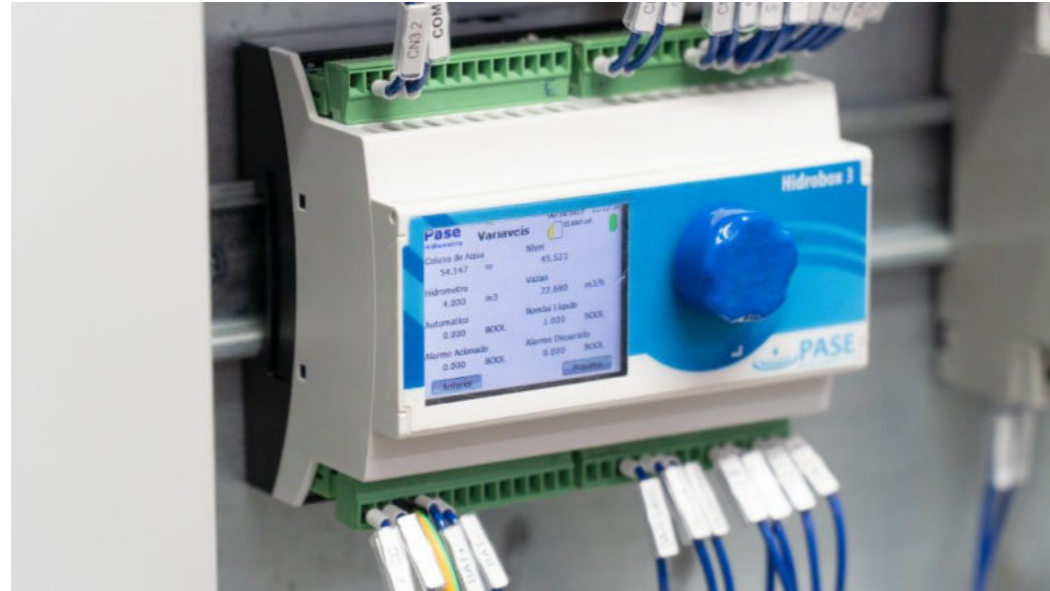
Figura 133-Modelo de automação para controle da vazão
