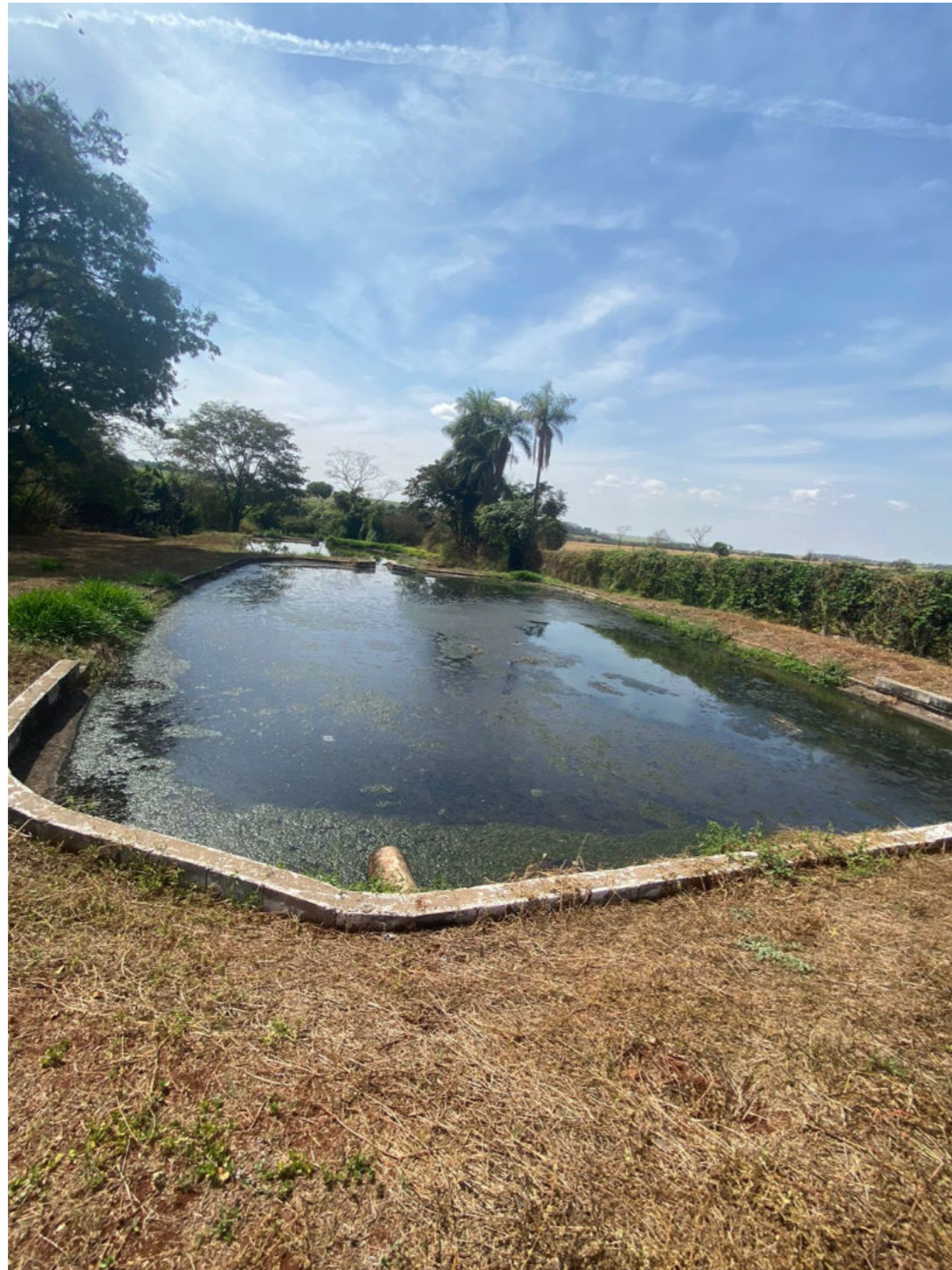
Figura 165 – Entrada do efluente na 1ª Lagoa Facultativa. (Parte 01)
