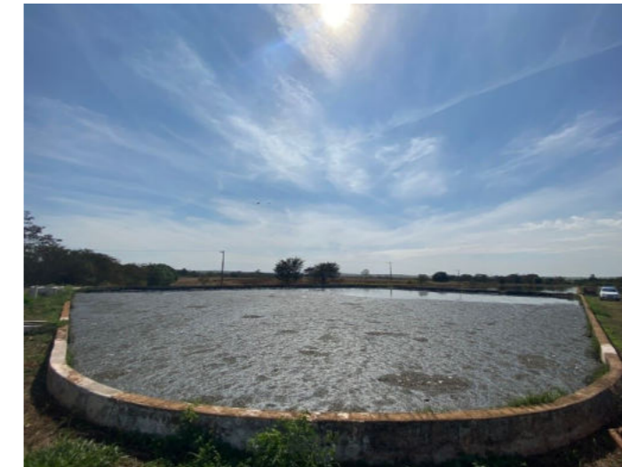
Figura 152 – Lagoa Anaeróbia (Parte 01)
