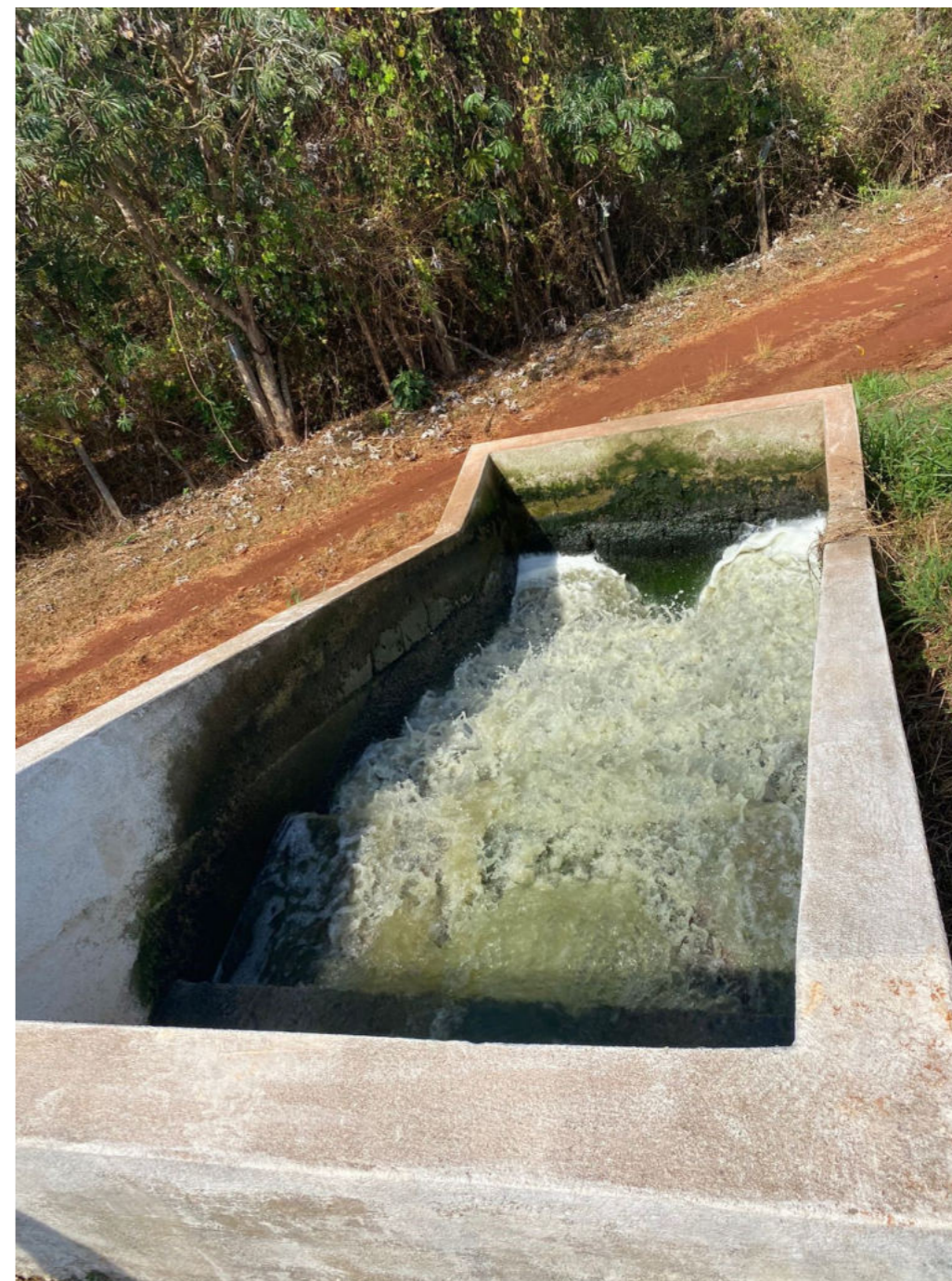
Figura 157 – Medição de Vazão na saída da ETE Guará.
