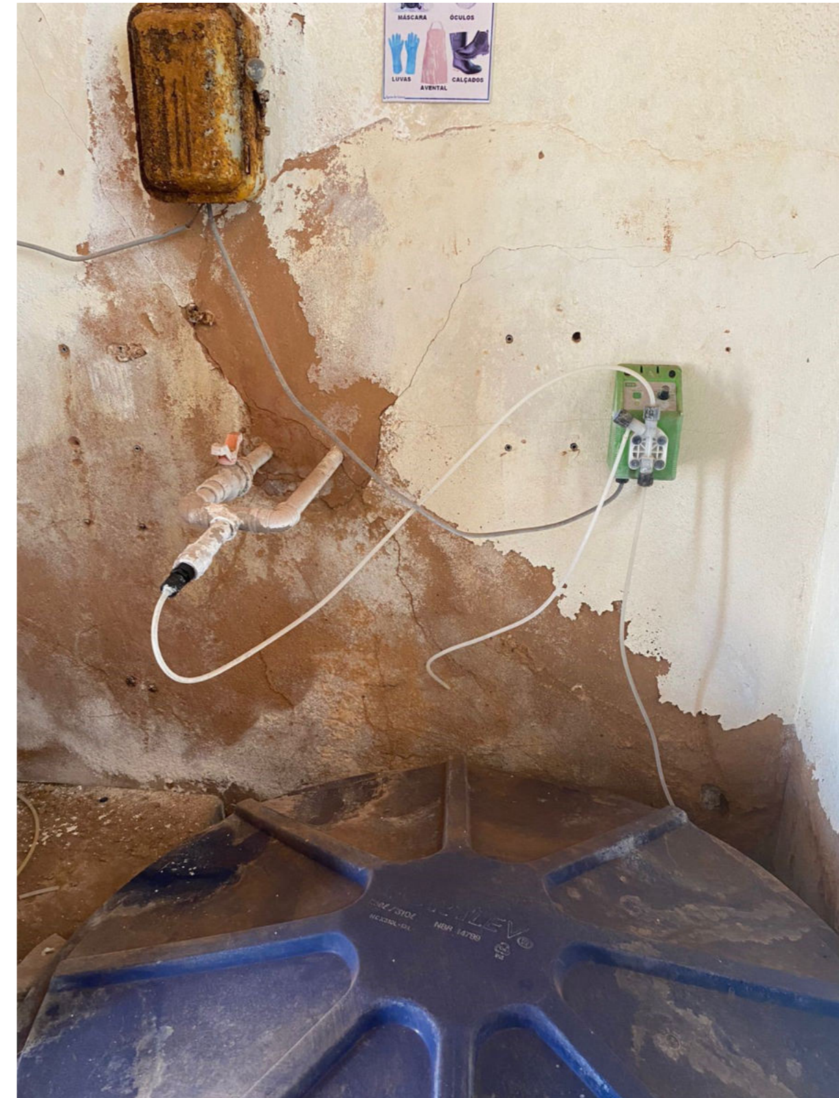
Figura 88 – Bomba dosadora de flúor.
