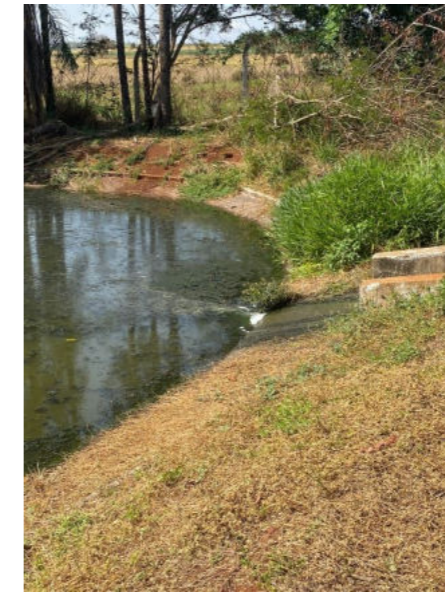
Figura 168 – Entrada do efluente na 2ª Lagoa Facultativa.
