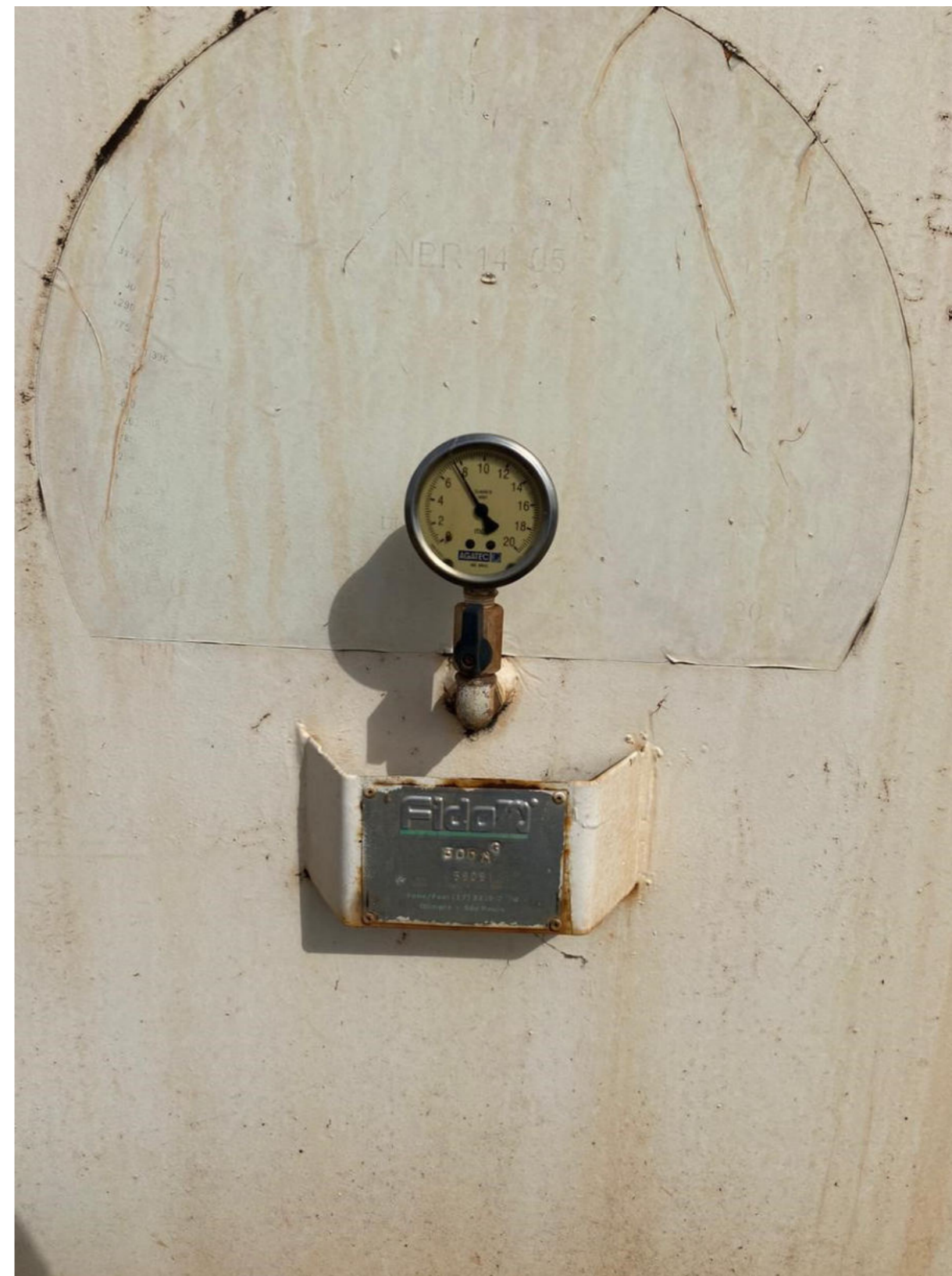
Figura 110 – Medidor de pressão – Res 11.
