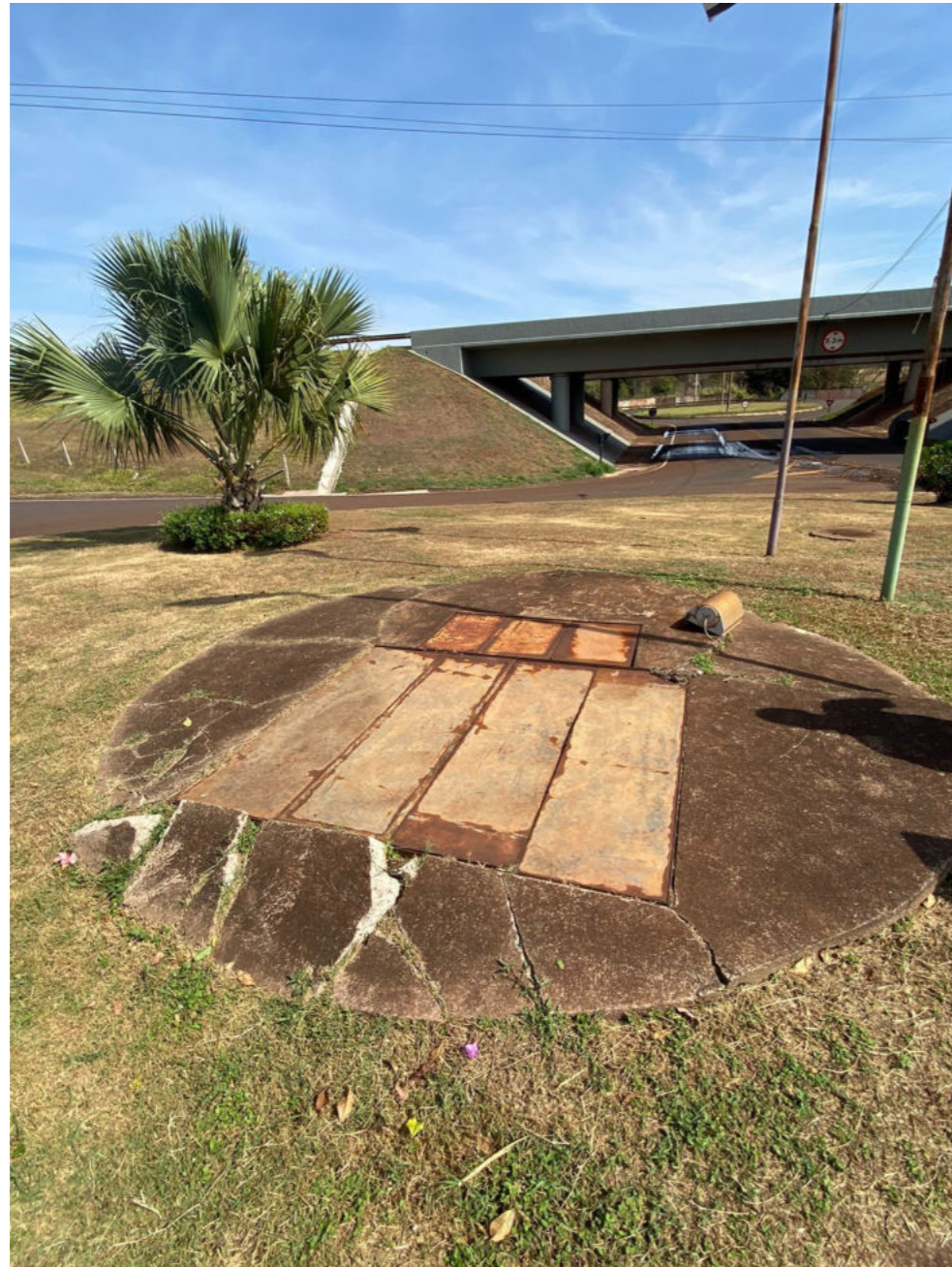
Figura 143 – Estação Elevatória de Esgoto Quinze de setembro.
