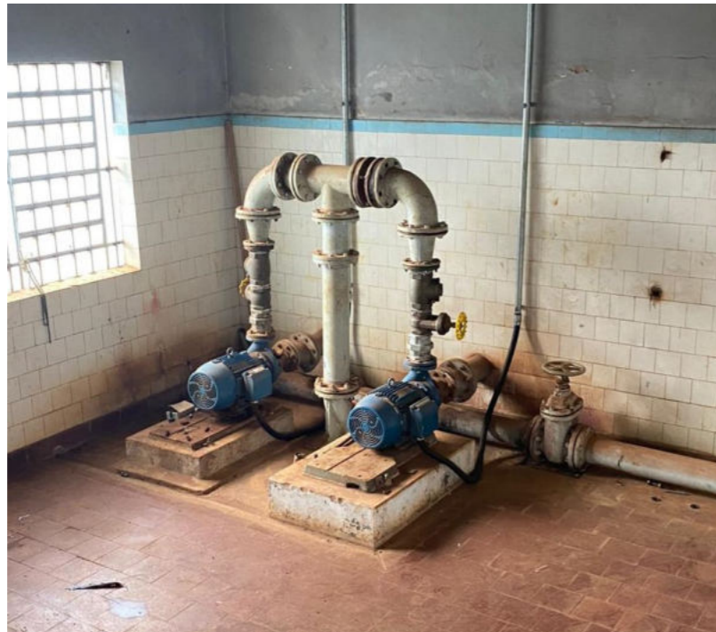
Figura 20 – Elevatórias para o poço UP06.
