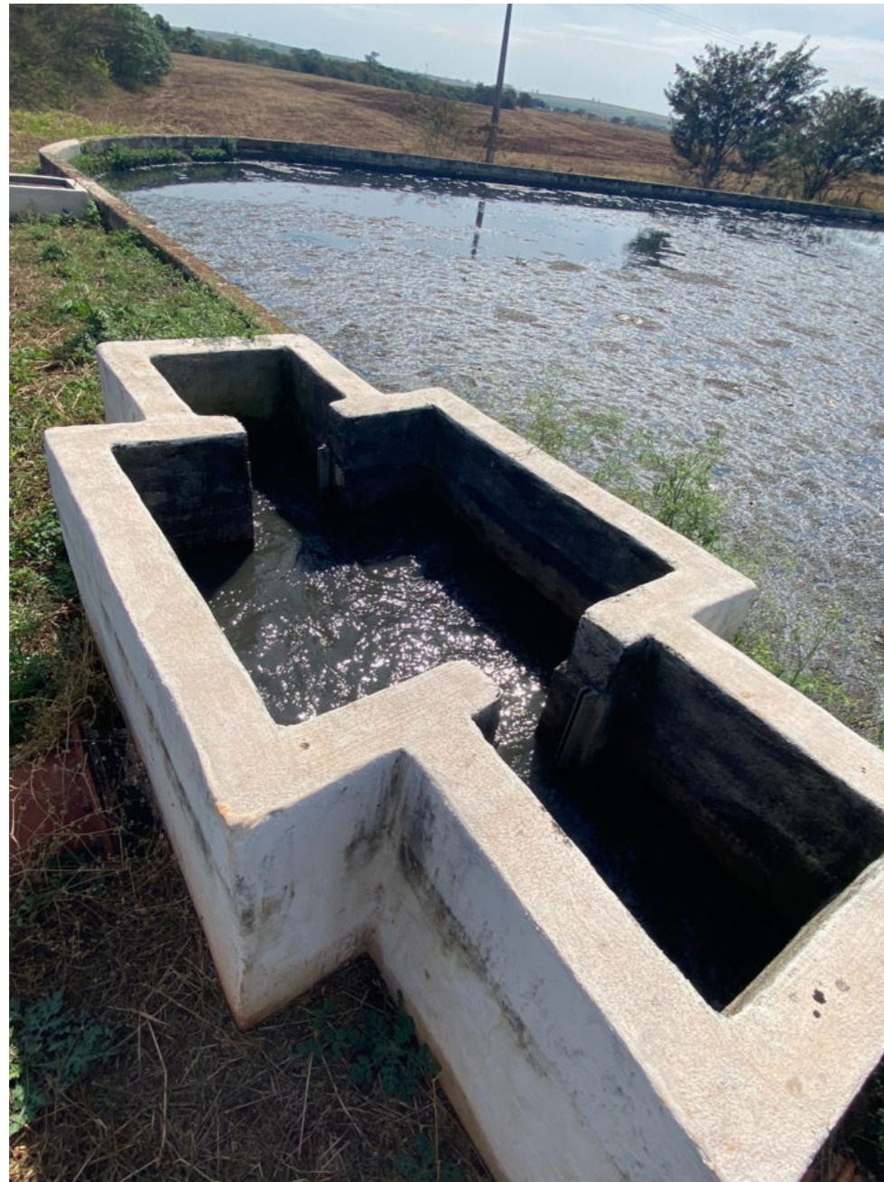
Figura 151 – Chegada do Efluente na Lagoa Anaeróbia.
