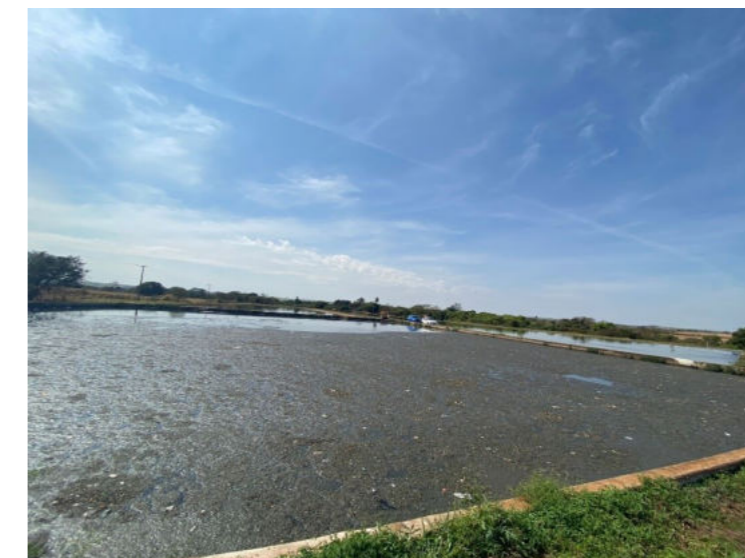
Figura 153 – Lagoa Anaeróbia (Parte 02)
