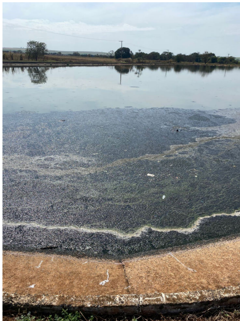
Figura 156 – Resíduos Sólidos no espelho da Lagoa Facultativa.
