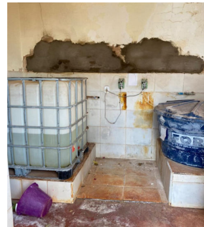
Figura 28 – Dosagem de cloro e flúor.
