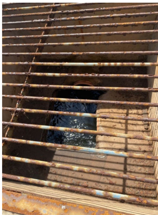
Figura 149 – Chegada do Efluente na ETE Guar.
